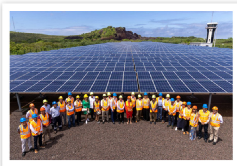
Sistema fotovoltaico Puerto Ayora
